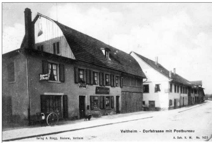
Postkarte von 1908. Vor der Bäckerei Stäuble gab es an der Bachtelstrasse 71 die Bäckerei Rüegg mit Postbüro. Rechts im Bild das Restaurant Apfelbaum.
